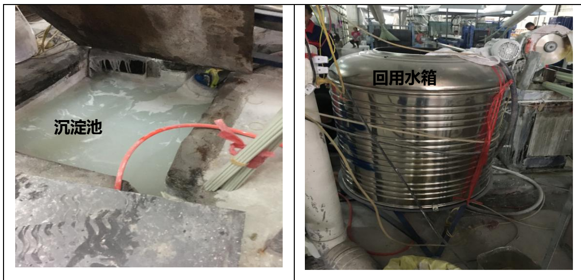
图 4-2 企业废水治理现场相关照片
